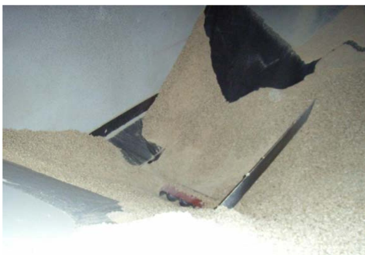
Bild 3 När pelletsen samlas i förrådet blir matningsskruven synlig. Risk för CO-exponering vid inträde. (Foto U. Svedberg)
