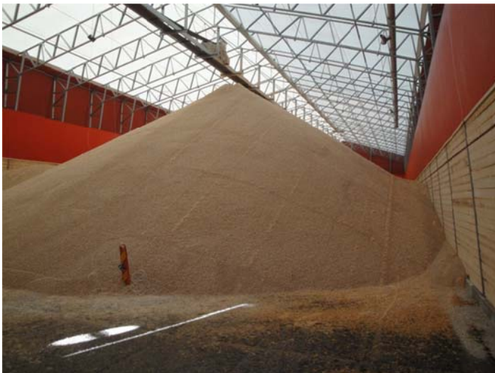
Bild 2 PVC-hall med träpellets.
