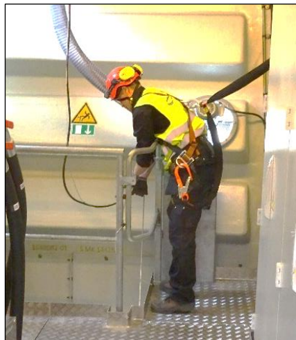
Bild 3. Utrymningslucka med skyddsräcke och sparklist.
