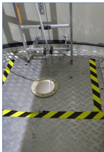
Bild 5. Vindkraftverk utan räcke
