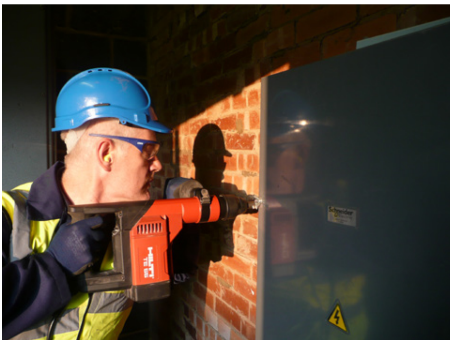
Figur 6.5 – Arbetstagare med ett maskindrivet handverktyg som hålls nära kroppen. I denna situation är exponeringen av kroppen och extremiteterna likartade och överensstämmelsen med låga/höga insatsnivåer är begränsande
